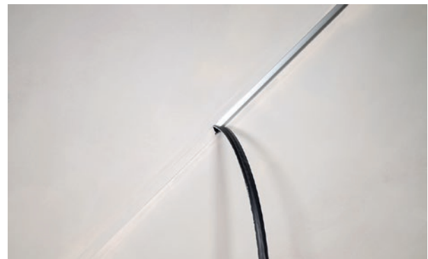
Nach dem Streichen den Schutzschlauch sowie Farb- und Putzreste entfernen
