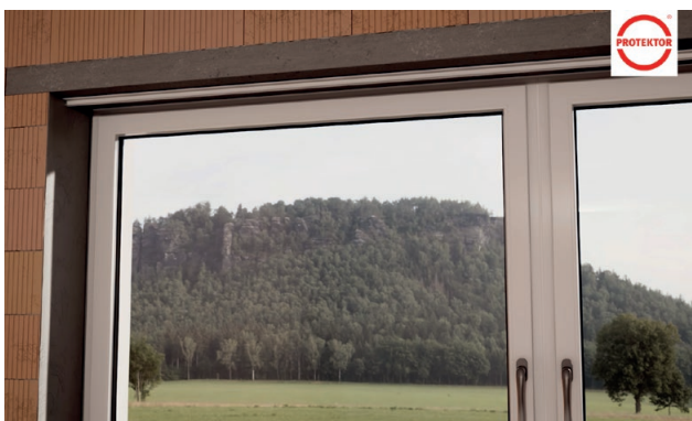
03 Fensterrahmen seitlich und im Sturzbereich mit dem SLP Universalreiniger reinigen und ablüften lassen. Einfassprofil auf das benötigte Maß ablängen, im Sturzbereich am Fensterstock ankleben und mit der Andrückrolle fest anpressen.
