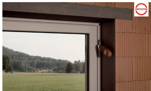
04 Anschließend das Einfassprofil auch seitlich am Fensterstock ankleben und ebenfalls mit der Andrückrolle anpressen.
