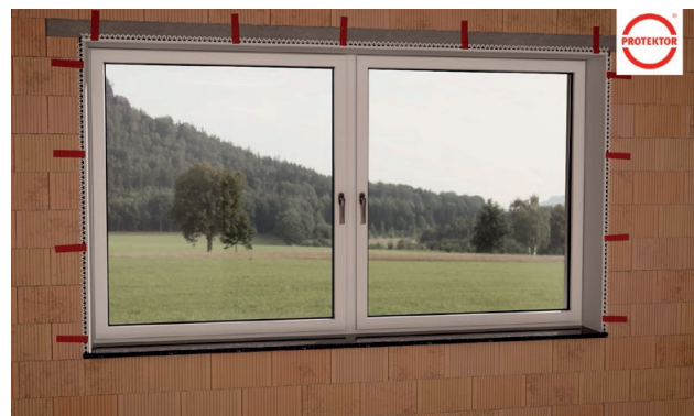
06 Seitliche SLP-Laibungsplatte ebenfalls in das Einfassprofil einschieben, wegklappen und im Kastenverfahren ausschäumen. Dann ebenfalls ausrichten und mit Klebeband fixieren. Details zur Fertigstellung im Video.
